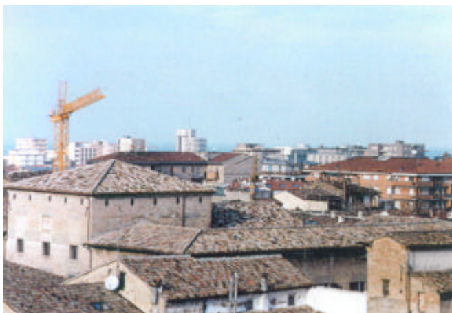
Veduta panoramica della copertura
