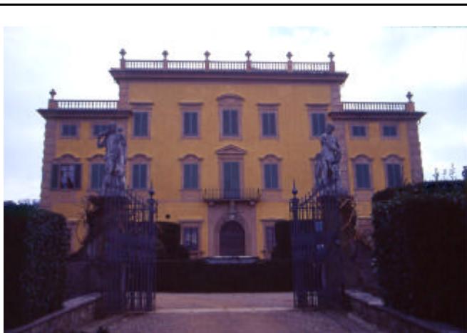
Veduta della Villa
