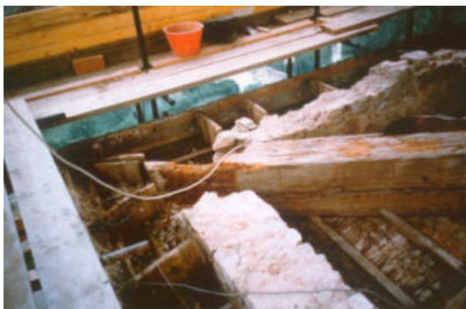
Particolare durante i lavori di restauro
