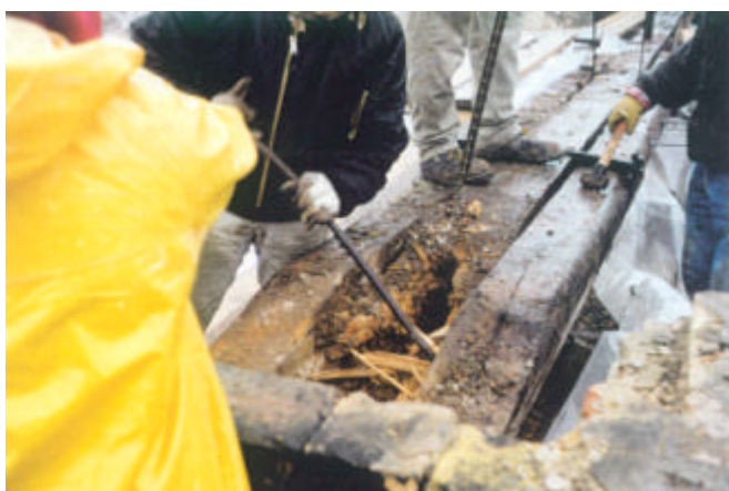
Particolare durante i lavori di restauro
