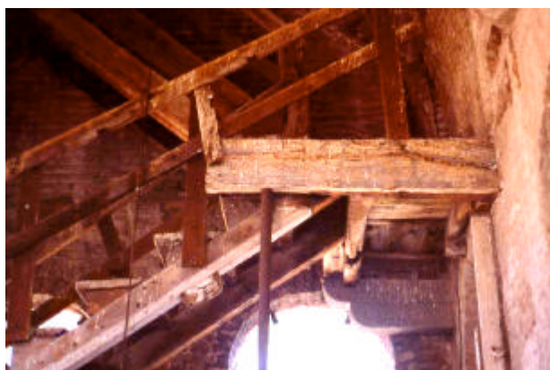
Particolare della scala interna
