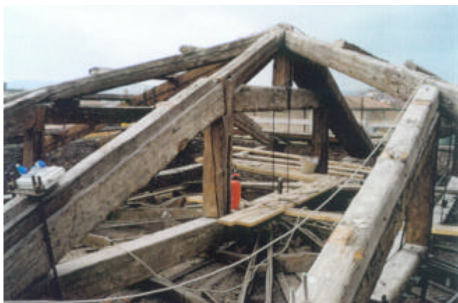
Aspetto della struttura durante i lavori di restauro
