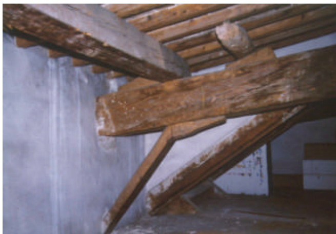
Particolare della orditura del tetto
