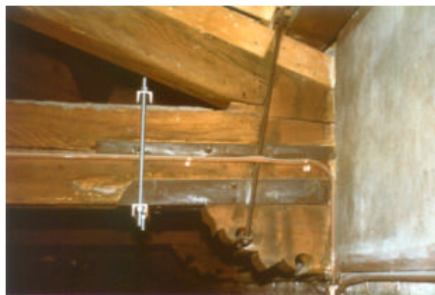
Foto 2 – Capriata C7: Veduta dell'appoggio Sx dal lato Posteriore
