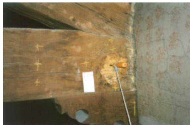
Foto 4 – Capriata C11: Veduta dell'appoggio Dx (lato Anteriore)
