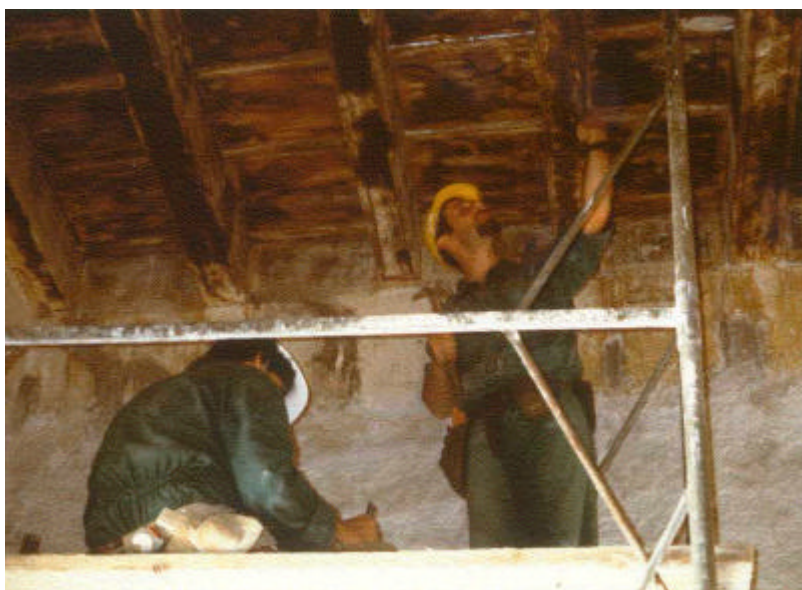
Ispezione visiva di un solaio
