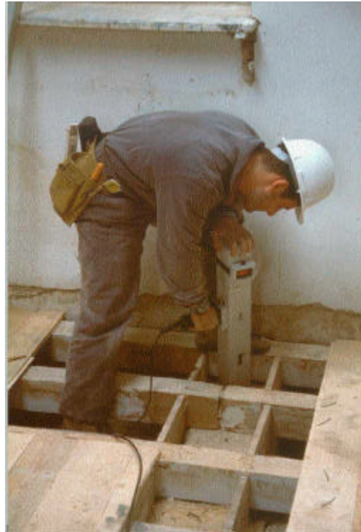
Indagine strumentale (resistografica) all'appoggio di una trave di solaio
