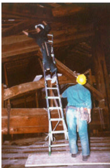
Ispezione visiva di una copertura
