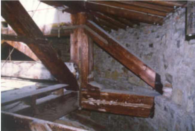
Particolare della struttura del lucernario
