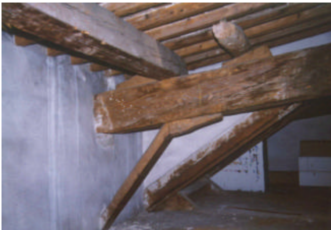
Particolare della orditura del tetto
