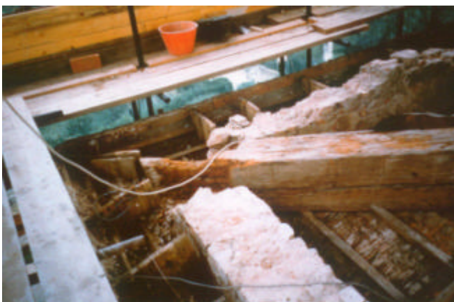
Particolare della orditura del tetto durante i lavori di restauro
