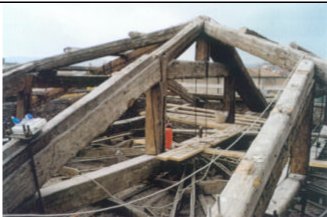
Aspetto della orditura principale della copertura durante i lavori di restauro
